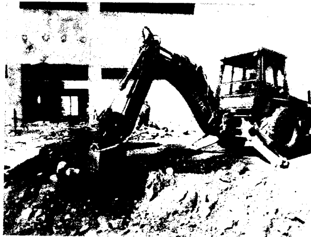
Foto 12: Excavaciones de patio de maniobras, caminos de acceso.
