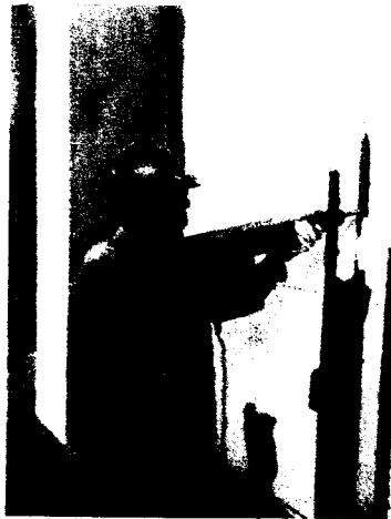
Foto 02: Picados en puntos eléctricos, modificados, IIEE.
