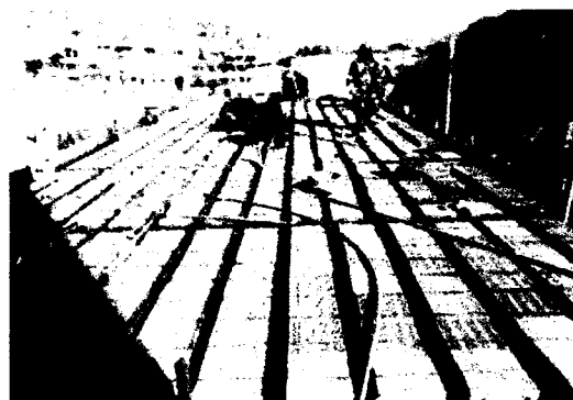
Fotografía N°18 Techo aligerado area serv.
