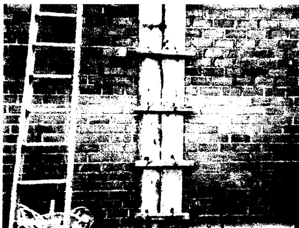
Foto 23: Encofrado de columnas, columnas de confinamiento.
